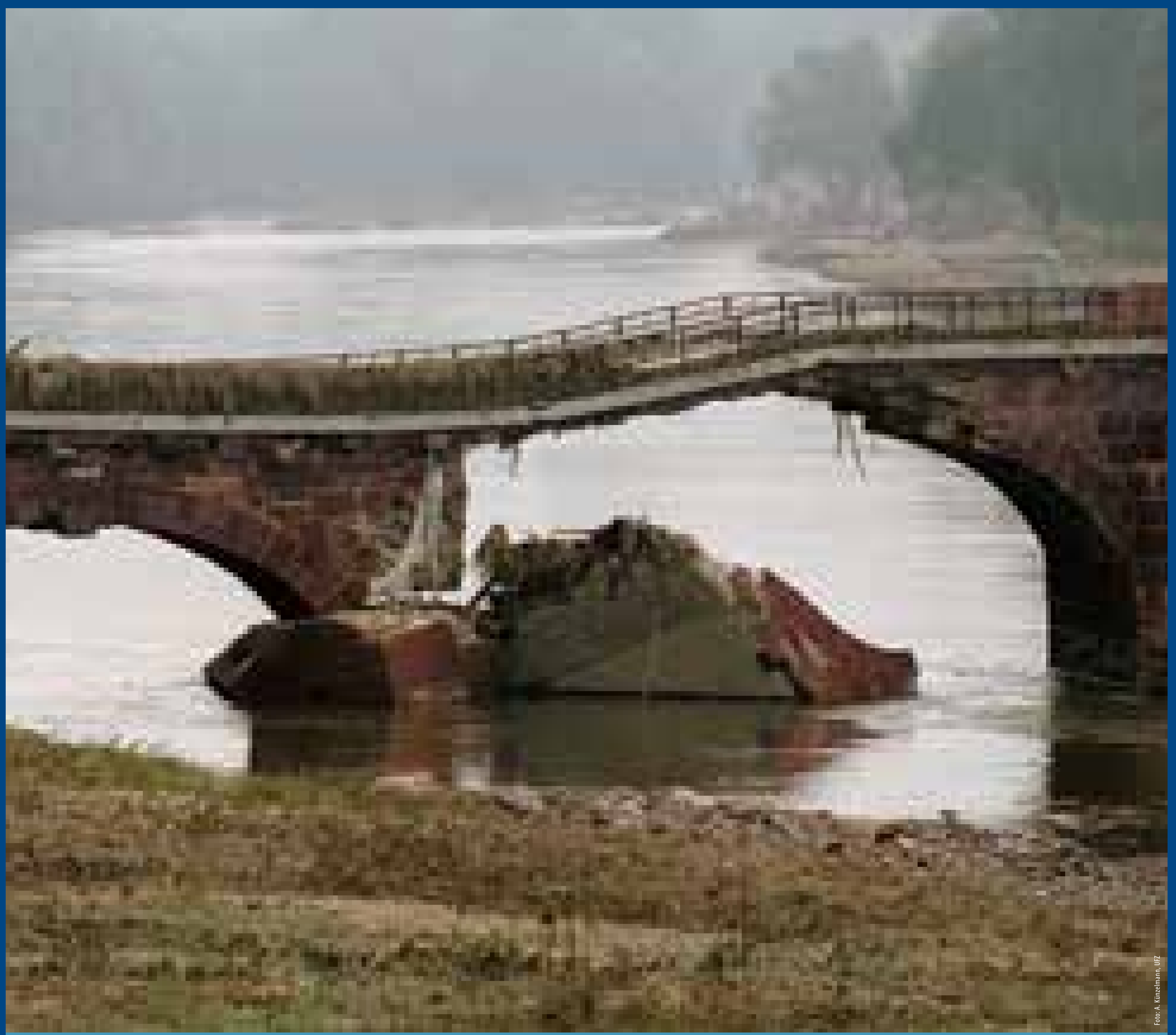
Zerstörerische Kraft des Wassers: Pöppelmann-Brücke, Grimma 2002
