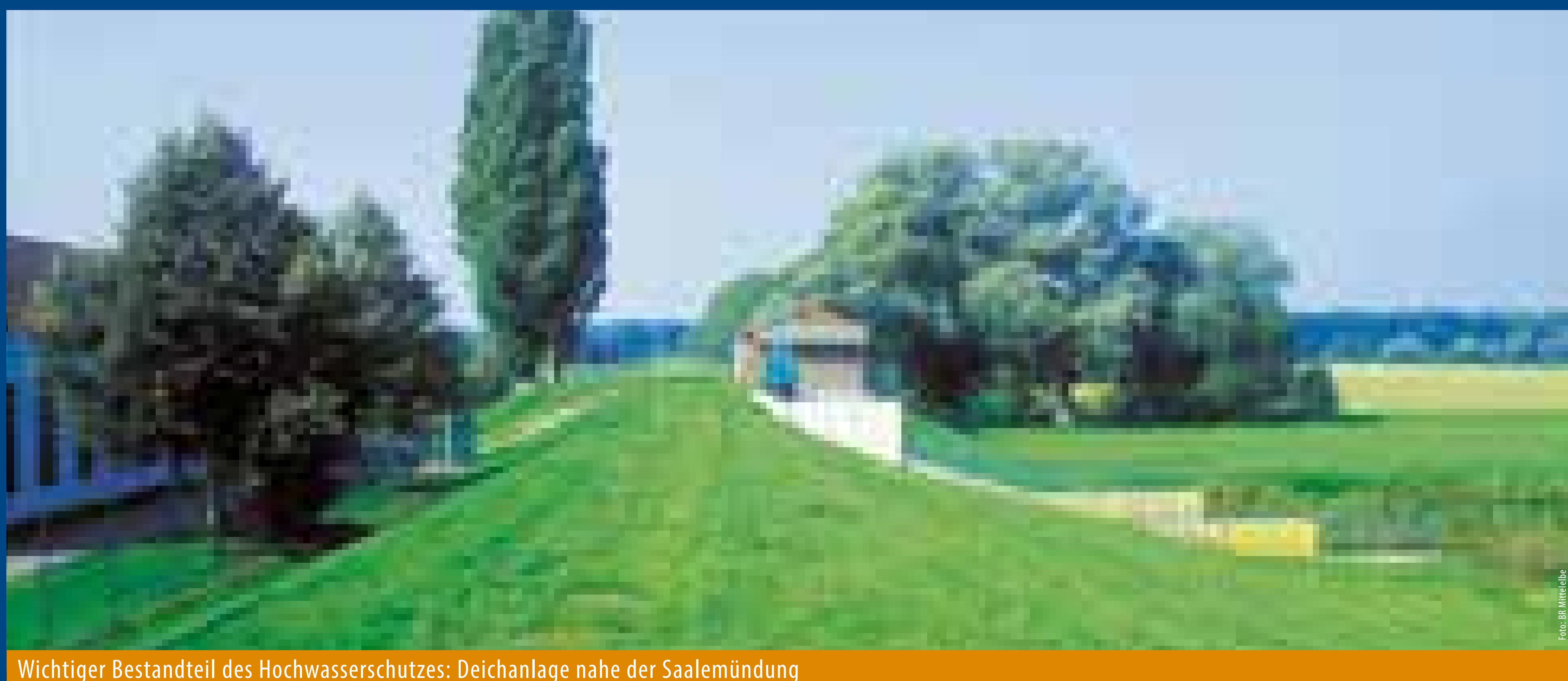
Wichtiger Bestandteil des Hochwasserschutzes: Deichanlage nahe der Saalemündung
