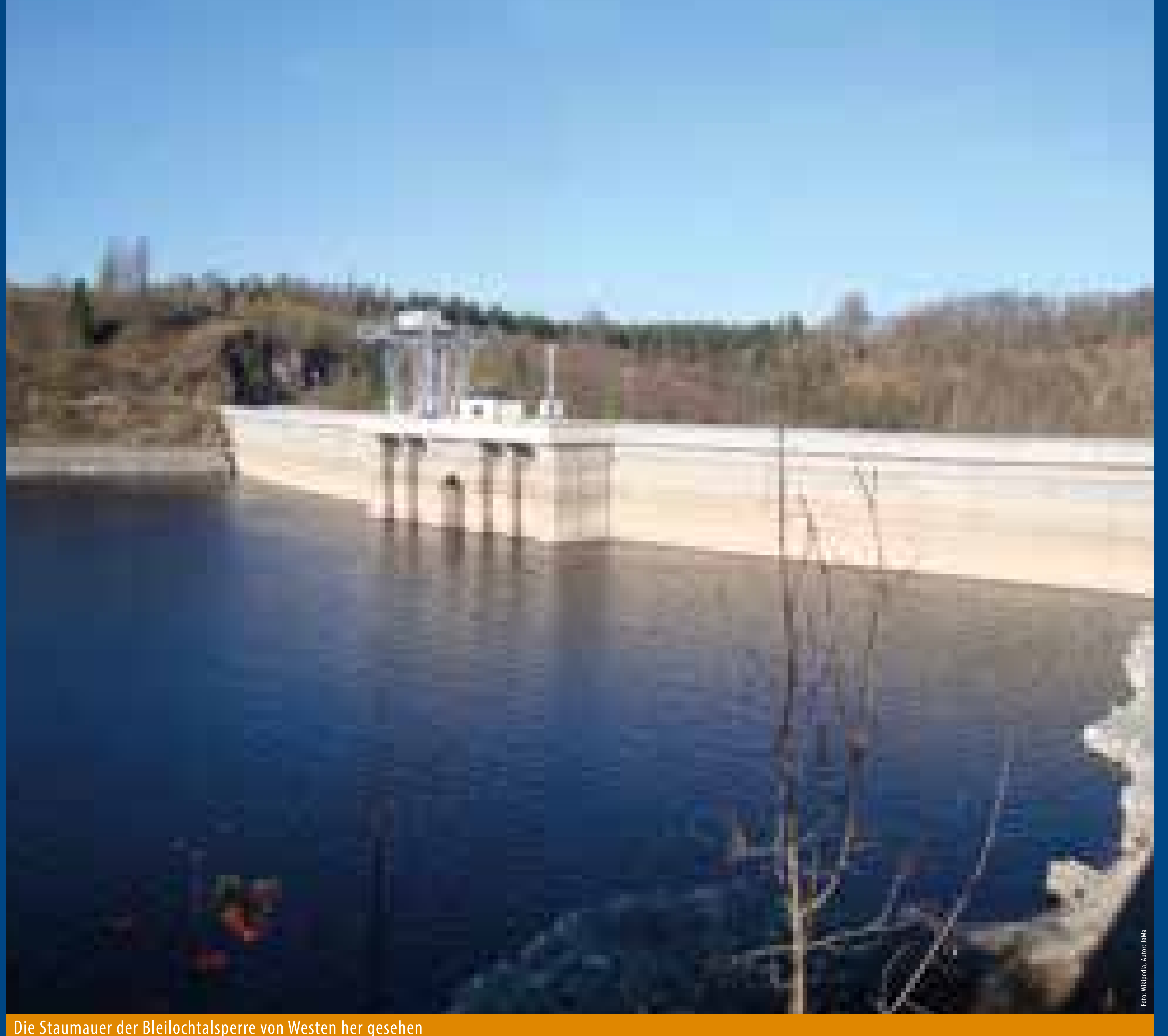
Die Staumauer der Bleilochtalsperre von Westen her gesehen
