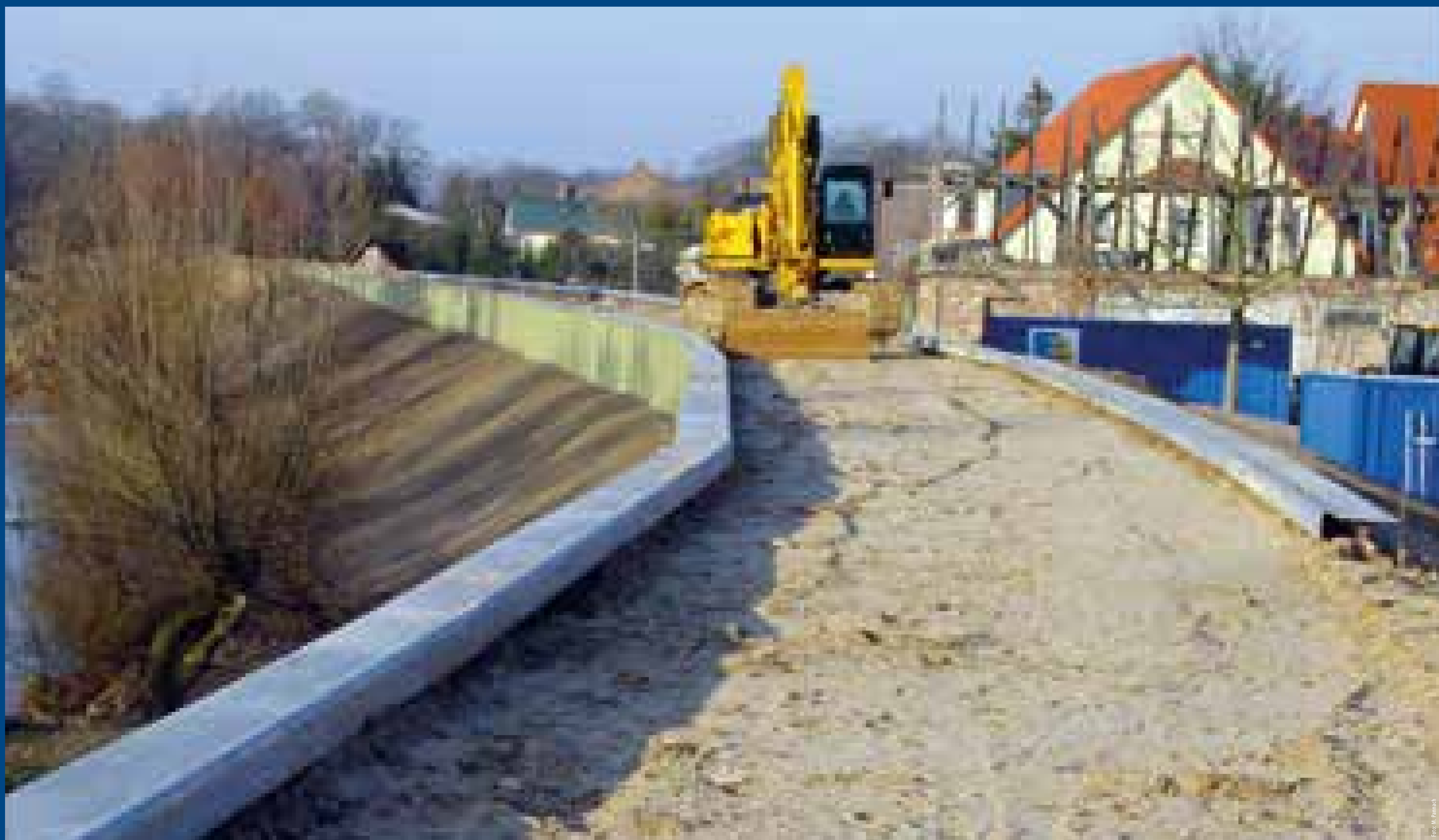
Beispielhaftes Projekt für Hochwasserschutz: Deichausbau an der Elbe
